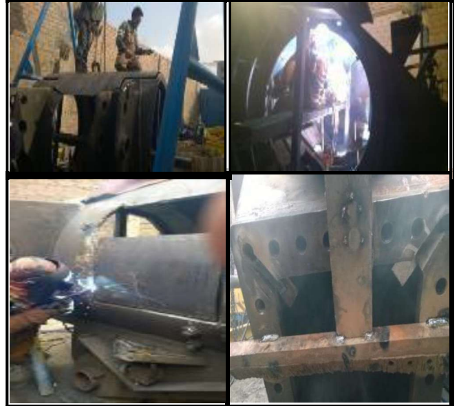
Foto, Durante el proceso de reparación del componente, Reparación de agujeros roscados de 1 ¼" NC.
